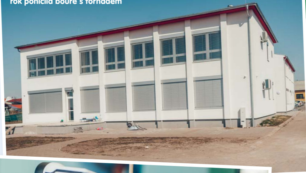
Nově zrekonstruovaná budova, kterou minulý rok poničila bouře s tornádem
